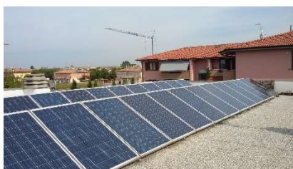
Vista Frontale Pannelli
